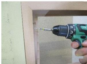
Fixer le châssis dans la cloison suivant la mise en œuvre conforme au PV feu
