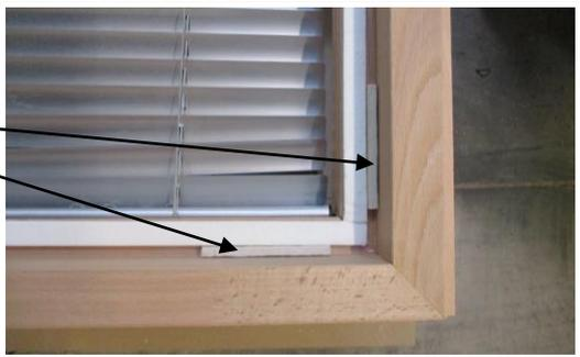
Poser le vitrage sur les cales SILICARTON prévues à cet effet. Assurer le maintien du vitrage dans le cadre en attendant la mise en place des parclose.
