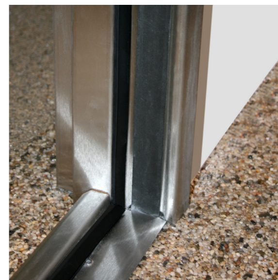
Seuil avec joints d'étanchéité à l'air
