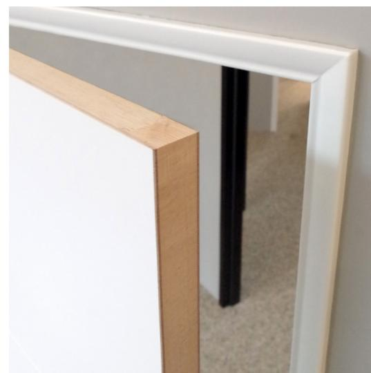
Détail du cadre en hêtre massif d'un bloc-porte à chant droit
